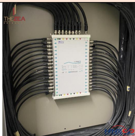
ระบบกระจายสัญญาณโทรศัพท์สดิจิตอล
